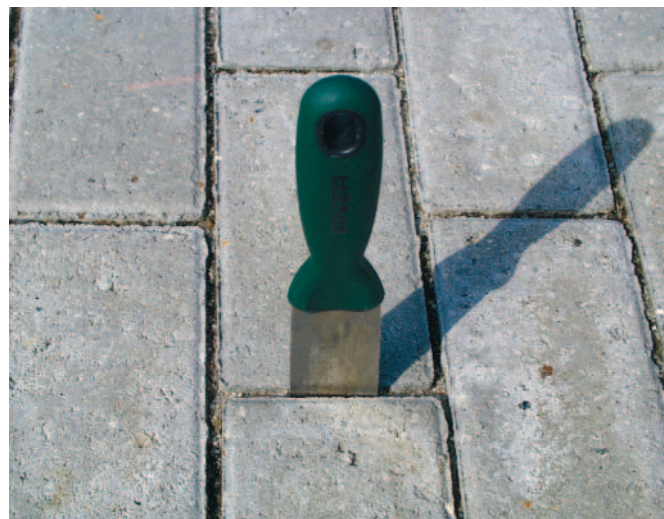
Fugesandet skal være tørt når det fejes ind i fugerne.
