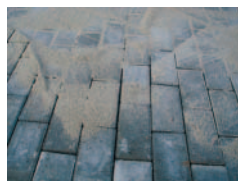
Fugesandet skal være tørt når det fejes ind i fugerne.
